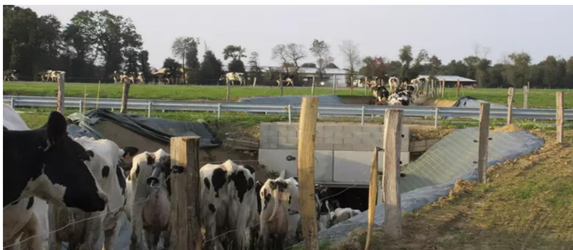
Figure 21 : Aménagement d'un boviduc pour rendre des prairies accessibles au pâturage (Pruilh, 2022b)
