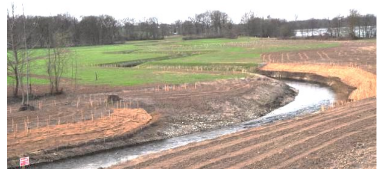
Travaux de restauration sur la Veyle en 2010 (Ain) Un nouveau lit a été créé afin de contourner une ancienne gravière. La maîtrise foncière a été essentielle pour la réalisation du projet (Cf. Bonnefond & Fournier, 2013)
